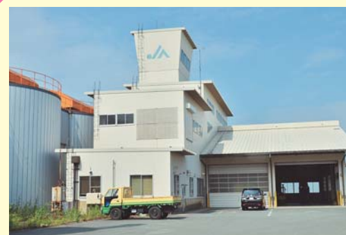
村山市中央カントリーエレベーター
